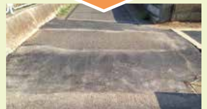
▲国分6丁目10番地先。段差が解消され安全に通行できるようになりました!
